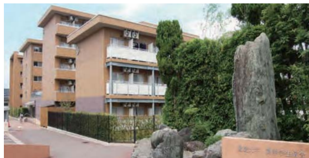
〈左奥から手前に向かって男子A棟、男子B棟、女子C棟、女子D棟〉 A棟(旧男子寮)とD棟(旧女子寮)は改築、B棟、C棟は新築されました。
