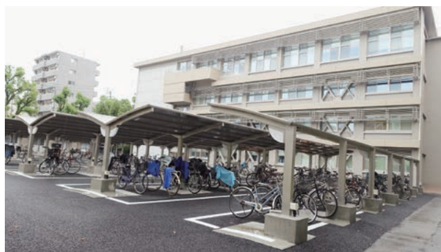
完成した屋根付き駐輪場
