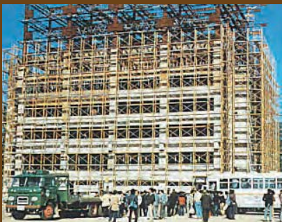
建設中の医学部(昭和48年)
